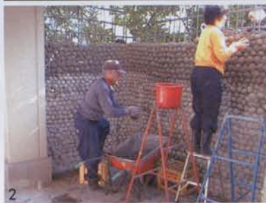
1「建築はもっと身近にあっていいもの」と考える海野さんならではの発想で極限までローテク化されたRCがこのだんご。強度や断熱を考えると、これだけで住宅全体を構成するのはかなり難しいが、例えば親子で休日に塀をつくるなど部分的な応用ならいくらでもできそう。 2 施工中の風景。右が渡辺さん。人間がやることなのでだんごの大きさやテクスチャーが日によって違い、それが微妙な地層となって現れているがそれも味わい。コンクリートはすぐに固まってしまうので時間との闘いでもあった。
