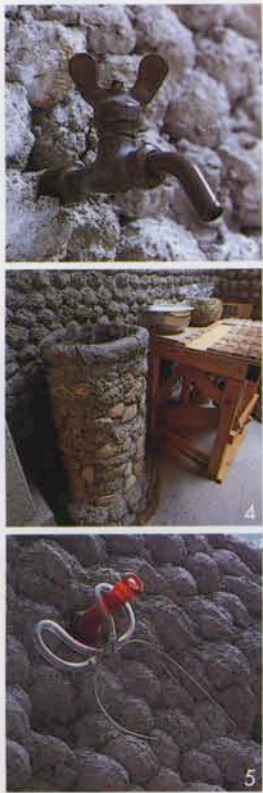
3 最初は水道も引いていなかったが、後から手洗い用に配管を引っ張った。 4 竣工後に渡辺さんが自分でセメントを買ってきて「海野さんのマネをして」つくってみた水受け。焼き物の破片を側面に張った。奥に見える台やテーブルも渡辺さんが手づくりした。 5 モノを引っ掛けるためのピンやコップを幾つか色を違えて組み込んだ。当初は海野さんの計らいで何か陶芸の作品をと考えていたが、軸葉がつるつるしてくっ付かず断念したそう。
