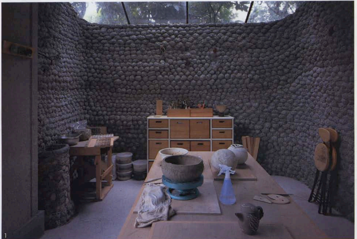
1「建築はもっと身近にあっていいもの」と考える海野さんならではの発想で極限までローテク化されたRCがこのだんご。強度や断熱を考えると、これだけで住宅全体を構成するのはかなり難しいが、例えば親子で休日に塀をつくるなど部分的な応用ならいくらでもできそう。 2 施工中の風景。右が渡辺さん。人間がやることなのでだんごの大きさやテクスチャーが日によって違い、それが微妙な地層となって現れているがそれも味わい。コンクリートはすぐに固まってしまうので時間との闘いでもあった。
