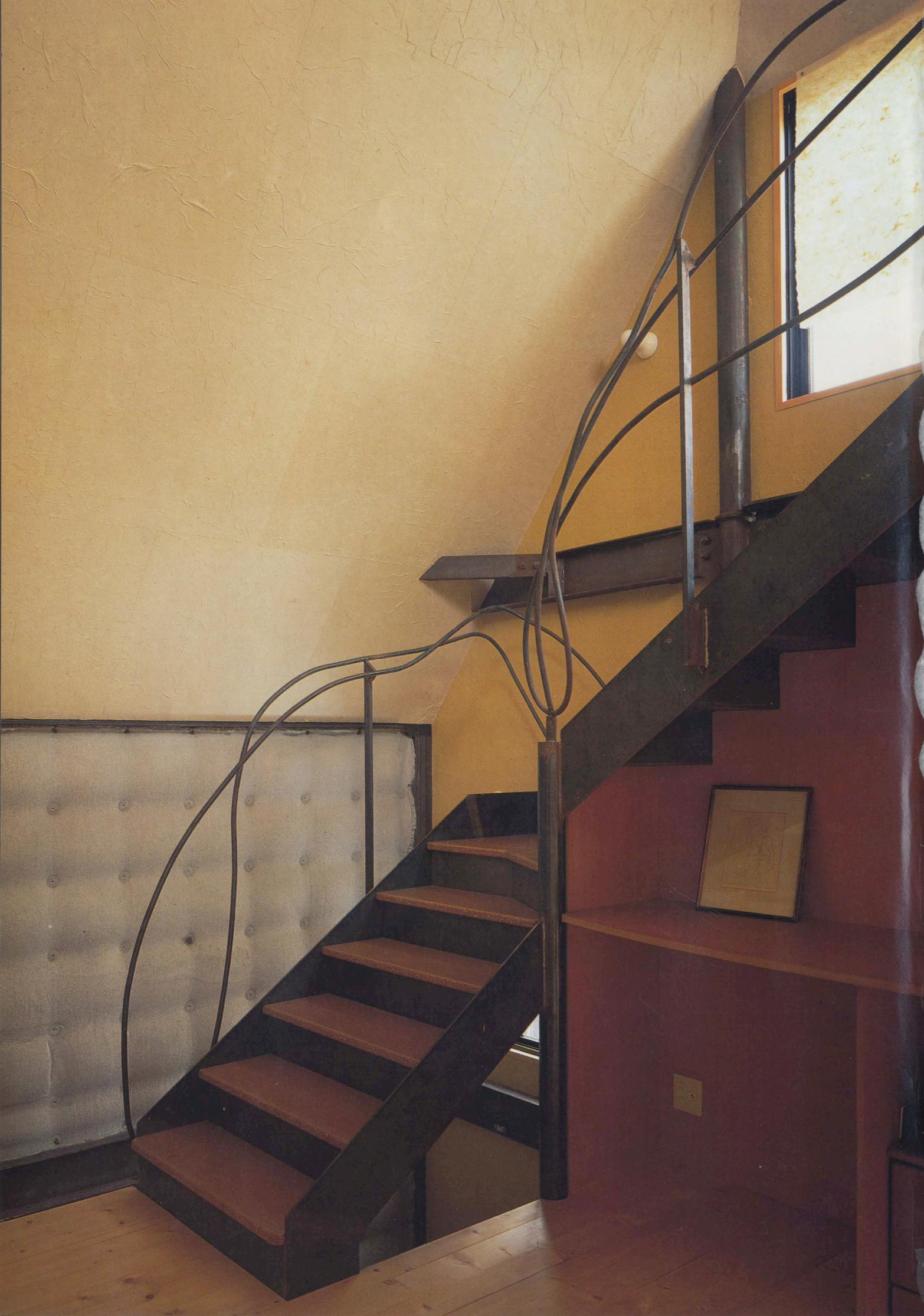
◀ 2階階段廻りをみる／URCの壁、鉄棒の手摺、天井の和紙、左官壁、異なる素材が織りなす空間。手摺は現場で曲げた。これも錆止めは塗っていないが手の油でだんだんいい艶が出てきた
