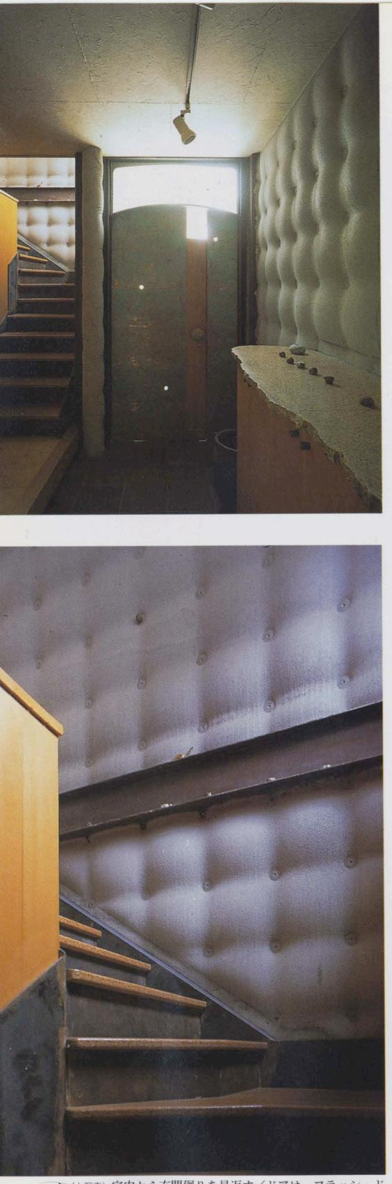
▲(上写真) 室内から玄関廻りを見返す／ドアは、フラッシュドアに銅板を張り、科学薬品で緑青に。三箇所アクリル棒をはじめこんだ小さな穴から光が射し込む。玄関右手の靴入れの上の石板は端材を利用したもの。決して高級品ではないが、見てわかる、触ってわかる、ごまかしのない誠実な、本物の素材だけがこの家で使われている
