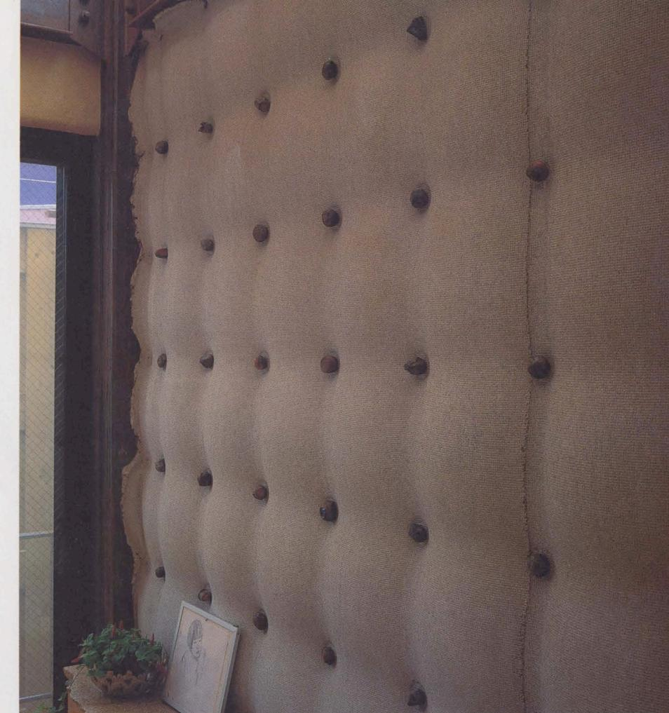
▲居間壁面（上写真）／近くで見ると非常に肌理が細かく、とても暖かい。URCの壁は蓄熱が非常に高く、夏は夜間の冷熱を、冬は1階アトリエ床の集熱パネルから得る温熱をためるので、冷暖房はほとんど使っていない。音響的にも優れており遮音性が高く、大音響でコードをかけてもご近所迷惑はなし。
