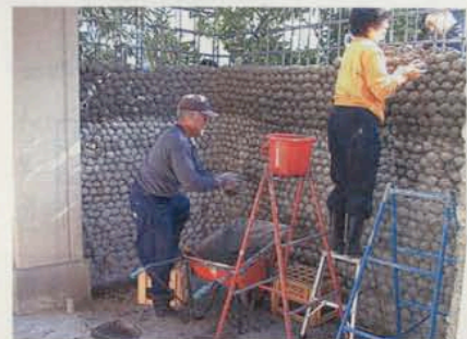
建て主も施工に参加した。変色しているところから、新たに搬入された生コンを使っている。下の方の団子がつぶれる問題は起きなかった。鉄筋に押し付けているからだと思われる(写真:海建築家工房)
