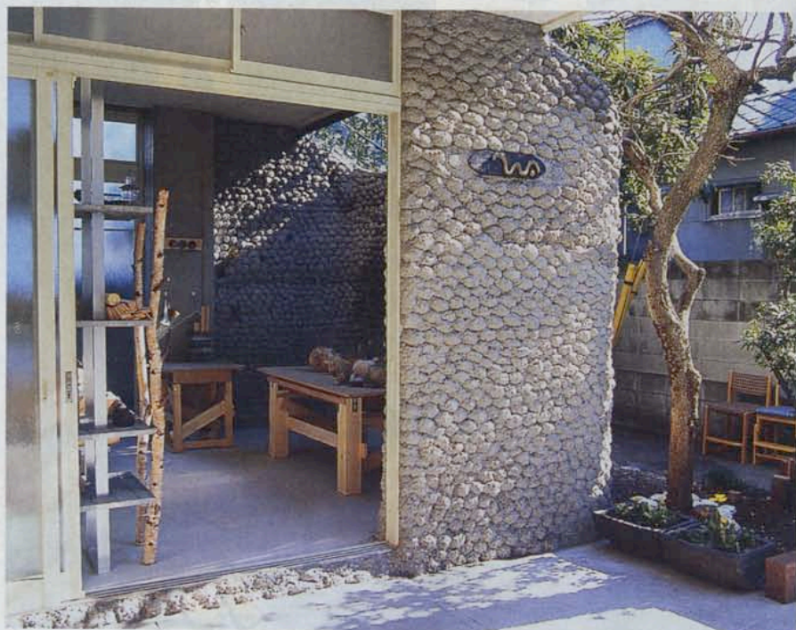
コンクリート壁の厚さは約250mm。外壁側はセラミックコートを施した。サッシは打ち込み式。建て主が選んだガラスピンなども所々にはめ込んだ。工事費は床暖房工事を含めて約200万円(写真:本誌)
