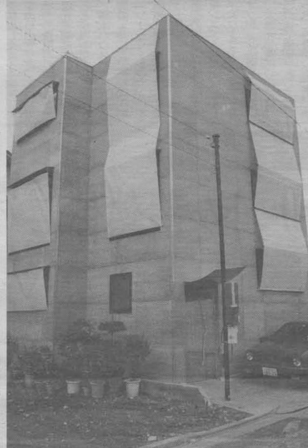
住宅の省エネルギー化を進めるため、様々な試みがなされている。東京の建築家・海野健三氏が設計した川崎市の実験住宅では、高蓄熱・自然換気により、空調に関してゼロエネルギーを実現している(2面のインタビュー参照)。夏は上の写真のように開口部をネットで覆って遮光する。このネットは海野氏が考案したURC工法で使われるのと同じもの。コンパネと違い、打ち放しの壁が波状になるので(左写真)、デザイン的にも面白いものになる。天井の真ん中の開口部が黒く見えるのは木炭が入っているから
