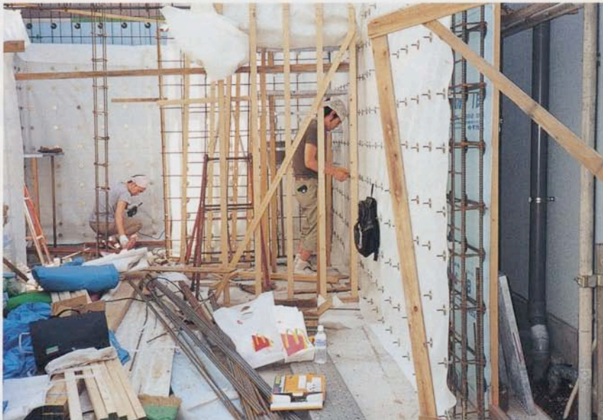
「URCハウス6」の施工風景。作業をしているのは建主のUさん。海建築家工房の方が事前に仮留めしてくれたネットの支持金物取付けを、休みの日や仕事の合間を縫って家族総出で行った。海野さんが手掛けたURC工法の中で建主が自ら参加したのはこの住宅が初めて。写真/建主提供
