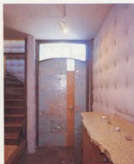
上●道行く人の目を惹き止める緑の外壁は、断熱材の外側にステンレス網を張り、その間に吸水効果のある土壌改良材ポーラストーン（多孔質セラミックス）を入れたもの。建物の4面にあり、上部から自動給水するシステムも備えている。敷地のコーナー部分は、プライバシーを確保するために木製の塙で囲んでいる。左●2階の吹き抜けと階段部分。手摺りは直径19mmの鉄棒を曲げたもの。鉄は素材感を活かすためにあえて無塗装にした。下●青く変色した銅製のドア、波打つコンクリート壁、天井の和紙など、様々な素材が楽しい表情を見せる玄関。
