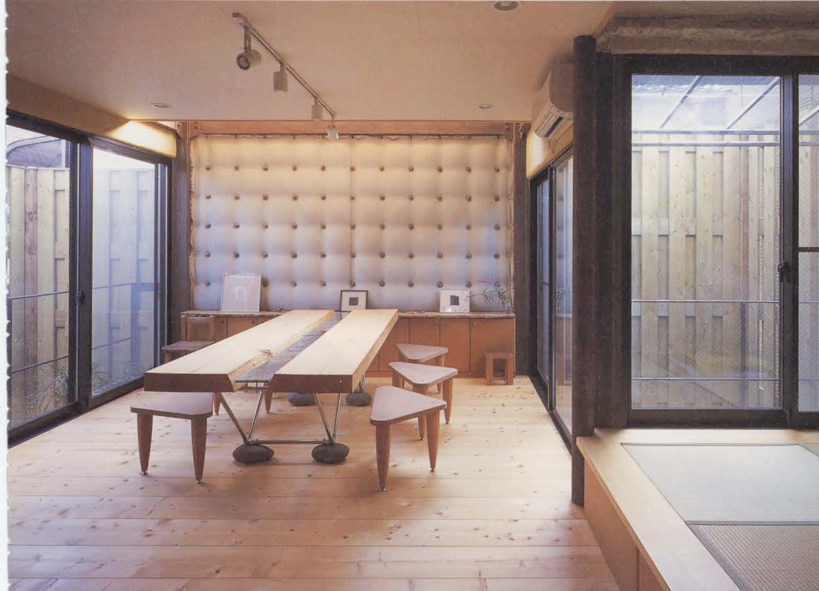
2階居間・食堂。トップライトや敷地四隅の「空き」から光をとり込んでいる。波打つ壁は海野さん考案のURC工法。従来のRC工法より容易でローコスト、手間のかかる外断熱のコンクリート壁も一気に完成できる（星野氏は斜線制限で建物形状が複雑になり鉄骨造を併用）。
