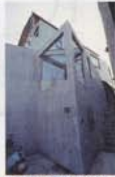
RC打設時の型枠材にOSBを使用している
