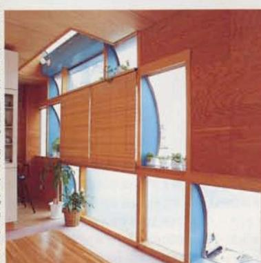
写真上、四階サンルームに造られたベンチは下町風情を感じさせる縁台風のデザイン。写真中、ボリカーボネイト製の曲窓の開閉部に使われた部品は、ヨットで使用されるもの。ここにも建築家のアイデアが生きている写真下、三階居間。内装は構造用合板、間仕切りや窓枠は“2×4”材を使用し低予算で仕上げている。
