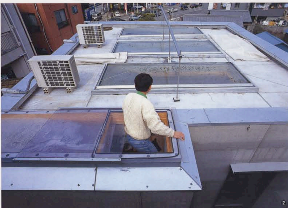
■水流邸 (本頁写真2点) ①3階子供室/天窗から入る太陽光が日中、コンクリートの壁面をじっくりと暖め蓄熱し、夜間はその熱を放熱する ②屋上/天窗は採光の他に、夏季には気化熱で室内を冷やす目的もある。水盤には炭を敷くことで蒸発する面積を増やし、気化を促す仕掛け
