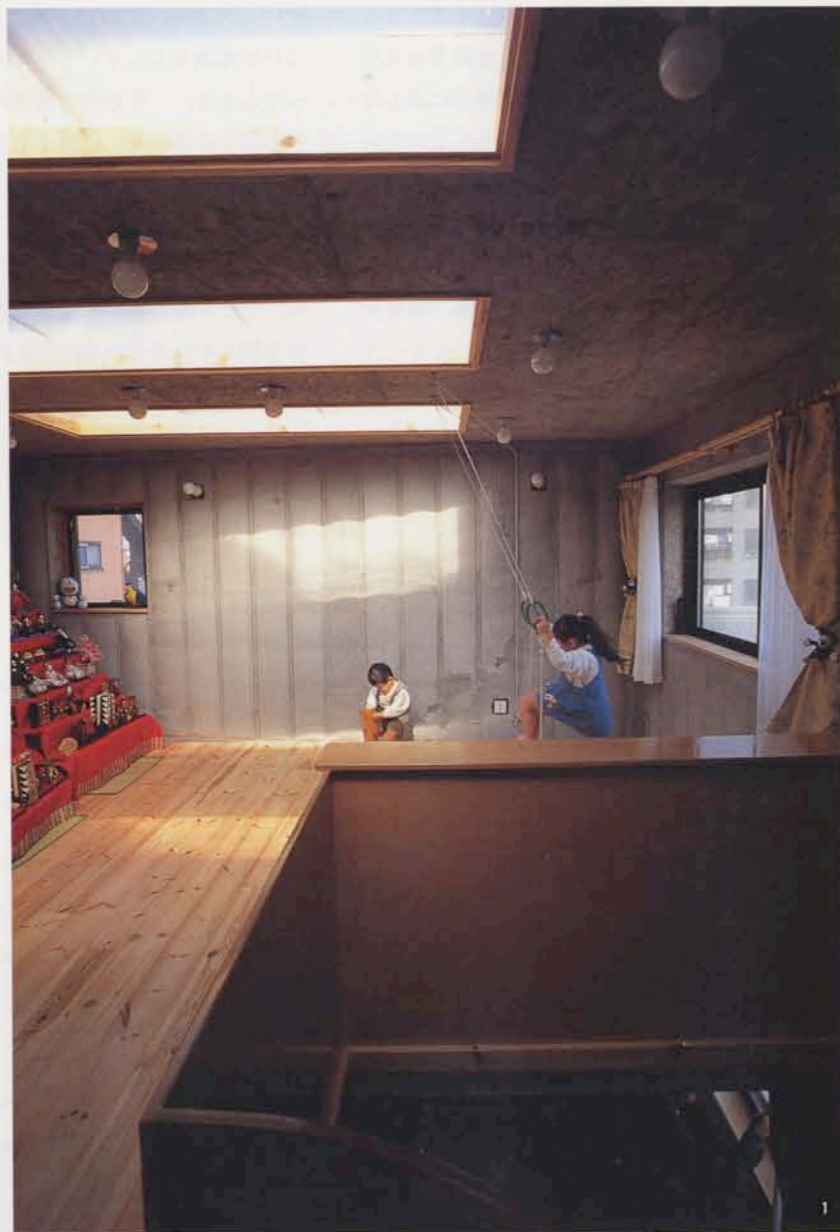
■水流邸 (本頁写真2点) ①3階子供室/天窗から入る太陽光が日中、コンクリートの壁面をじっくりと暖め蓄熱し、夜間はその熱を放熱する ②屋上/天窗は採光の他に、夏季には気化熱で室内を冷やす目的もある。水盤には炭を敷くことで蒸発する面積を増やし、気化を促す仕掛け
