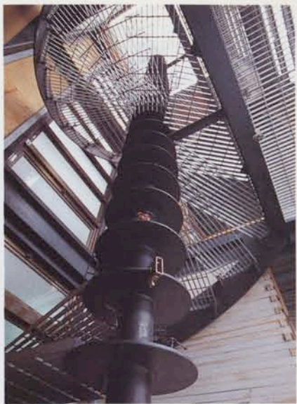
海運工場の螺旋階段。事務所もセルフビルドだ。
