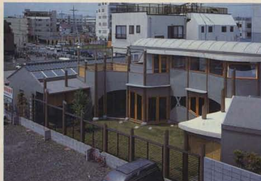
「木立の中の家」(東京都江戸川区)。91年2月竣工。林立させた丸木で建物を構成している。「林の中の日だまり空間」をつくることを意図した。総工費は4000万円。敷地面積326㎡。延べ面積248㎡
