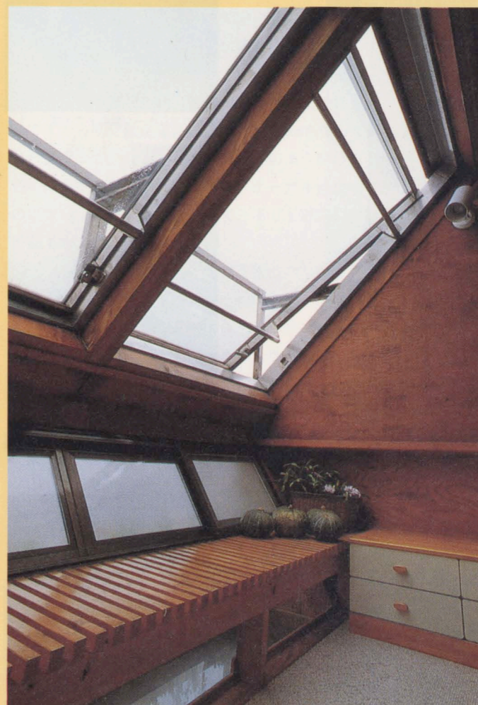
屋根裏に設けられたサンルーム 押し出し窓はオリジナルで50kg以上の重さがある ベンチの下はガラス張りです階の居間へ光を落としている
