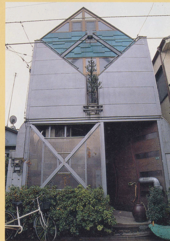
東側外観 右下に排水管を利用した郵便受けが見える
